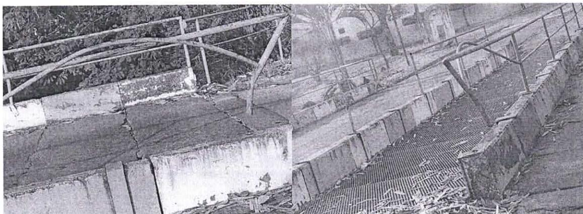
A presente indicação é justa e necessária tendo em vista que a referida ponte se encontra em péssimas condições de conservação, com muitos buracos, grades de proteção danificadas e necessitando de pintura, conforme se verifica nas fotos acima.
