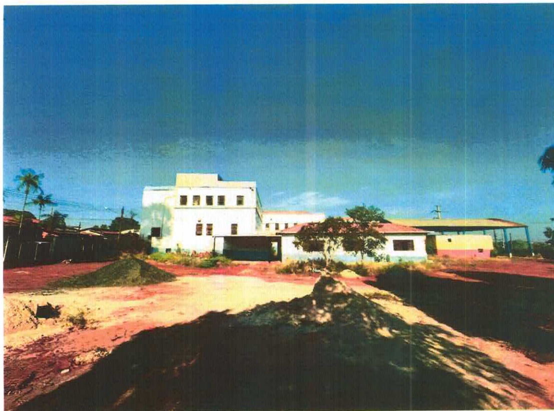
Figura 5 - Vista lateral interna (estacionamento)
