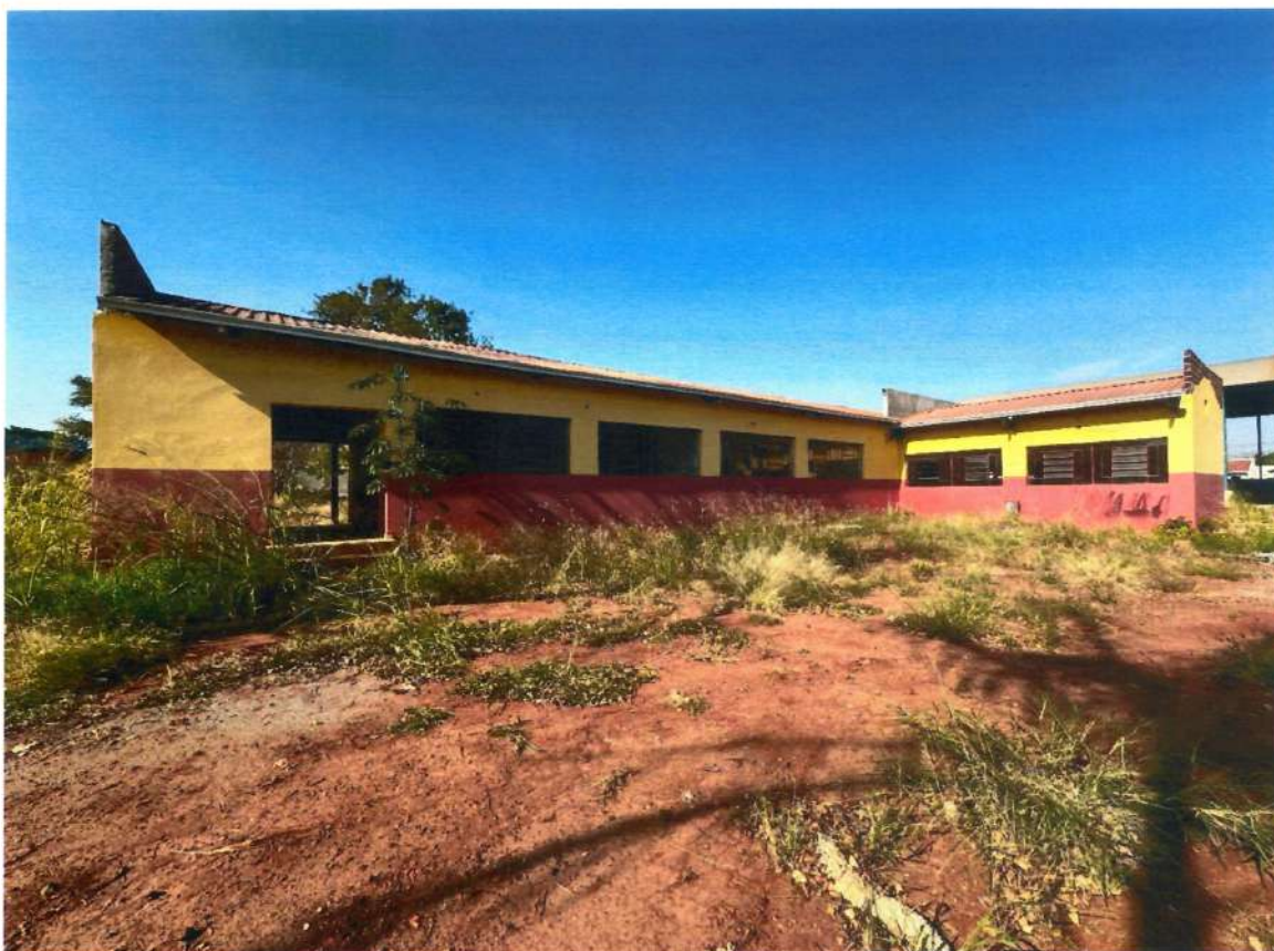
Figura 9 - Visão lateral do prédio 02
